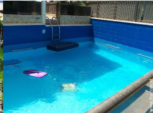
Swimmingpool in Wohnanlage
